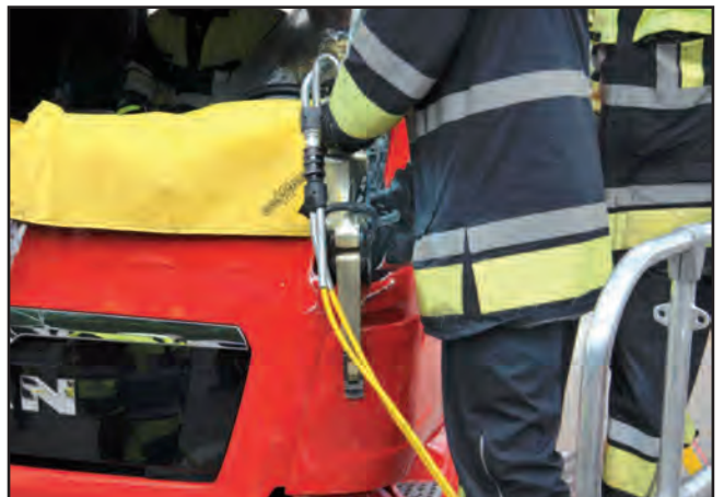
Luftleitkörper entfernen
